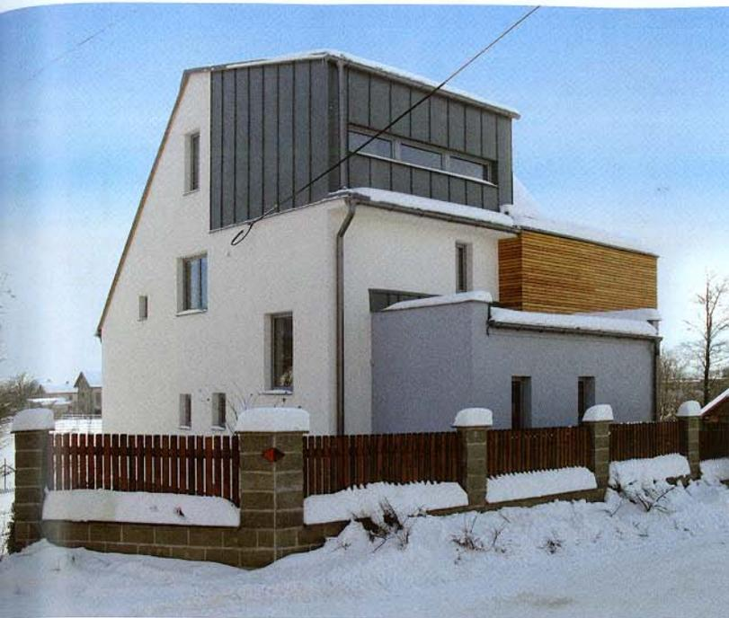
Schéma tří odlišných přístaveb nejlépe vynikne při pohledu ze severní strany: hladce omítnutá vstupní partie v přízemí, dřevem obložená kvádr v patře a oplechovaná přístavba s pultovou střechou, která navazuje na nejvyšší část podkrovní
